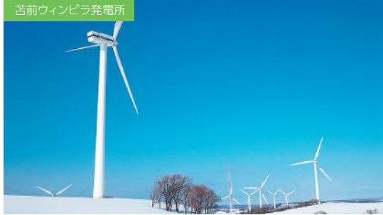
苫前ウィンビラ発電所
