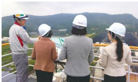
審査における発電所視察の様子(松島火力発電所/長崎県)
