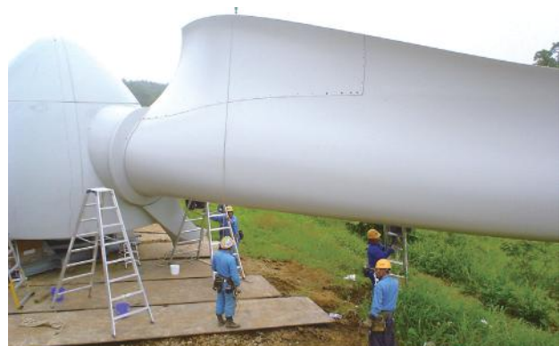
組立の様子(風車の羽部分)
