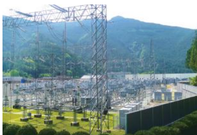
佐久間周波数変換所(静岡県) 東日本50Hzと西日本60Hzの異なる周波数間での電力融通を可能にし、電力の効率運用を図るために設けられた世界初の電気事業用周波数変換設備です。
