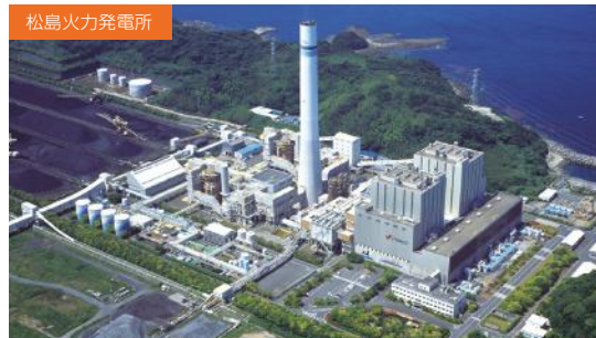
松島火力発電所
