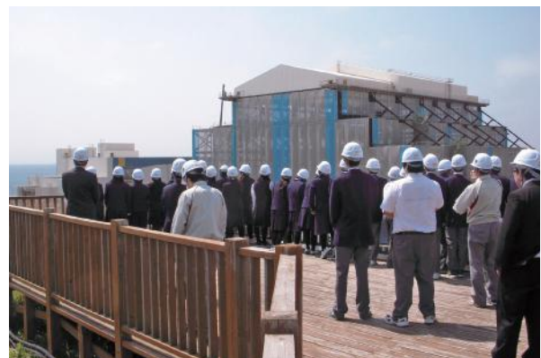
地元高校生が大間原子力発電所の建設現場を見学
