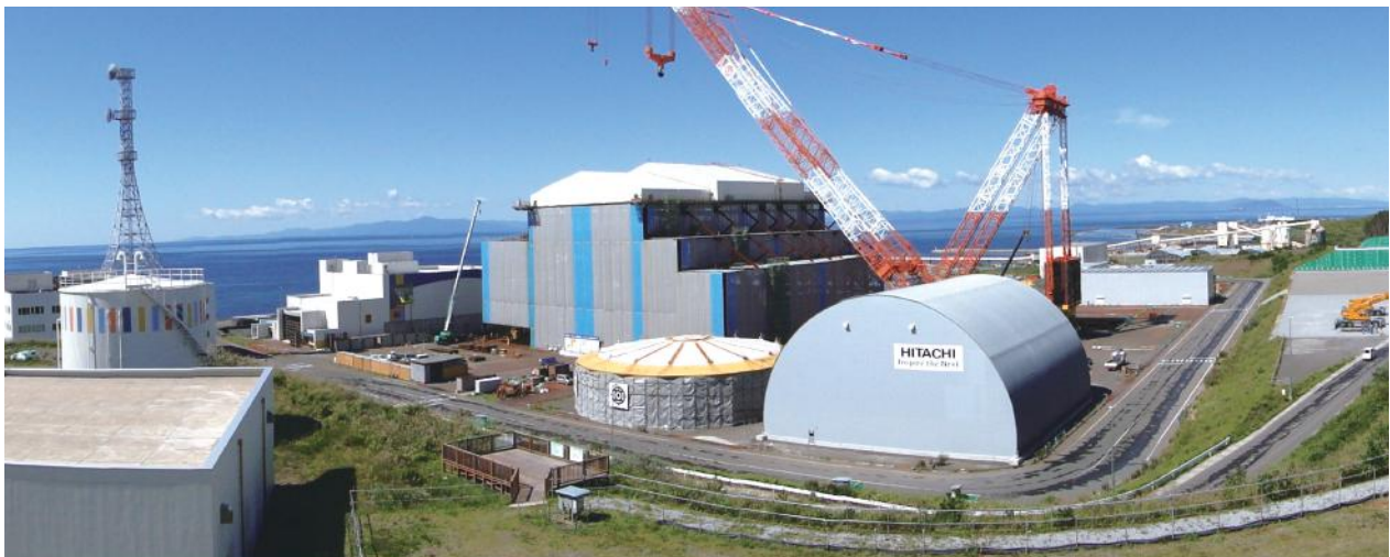
大間原子力発電所建設工事状況全景(青森県)
