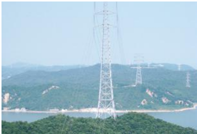
本四連系線(岡山県・香川県) 瀬戸内海を横断し、本州と四国をつなぐ電圧50万ボルトの送電線です。本州・四国の基幹送電線と連結し、西日本における電力安定供給に役立っています。
