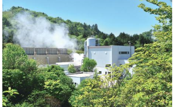
鬼首地熱発電所(宮城県)
