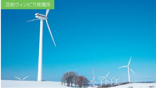
苫前ウィンビラ発電所
