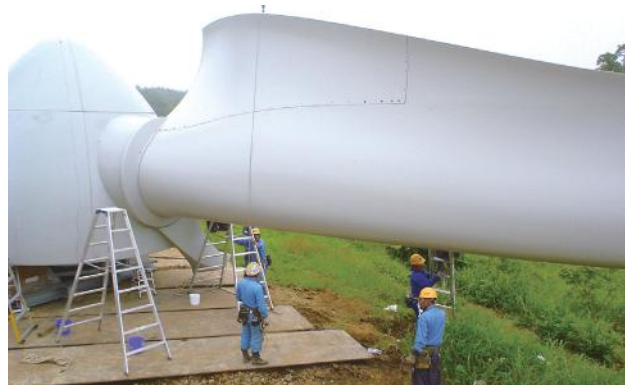
組立の様子(風車の羽部分)
