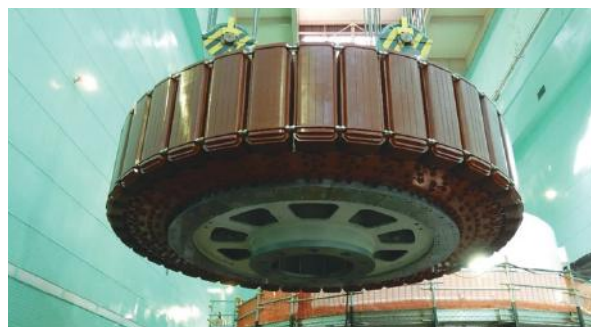
秋葉第二発電所の回転子吊り上げの様子(静岡県)
