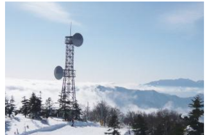
高杖無線中継局(福島県) 発電所や変電所などを結ぶマイクロ波無線中継局です。山上に位置し厳しい自然条件にありますが、災害時にも通信が途絶することのないよう高い信頼性を有しています。
