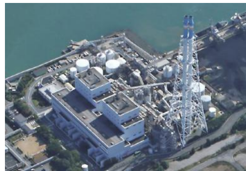
高砂火力発電所(兵庫県)
