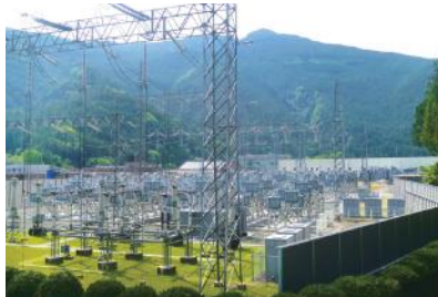
佐久間周波数変換所(静岡県) 東日本50Hzと西日本60Hzの異なる周波数間での電力融通を可能にし、電力の効率運用を図るために設けられた世界初の電気事業用周波数変換設備です。
