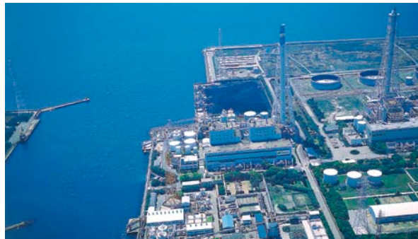
高砂火力発電所(兵庫県)
