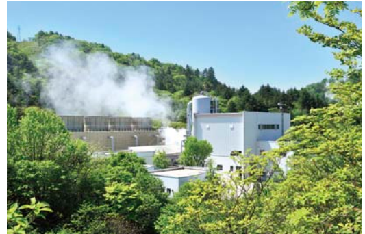
鬼首地熱発電所（宮城県）
