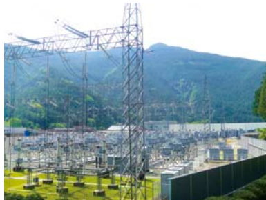
佐久間周波数変換所(静岡県) 東日本50Hzと西日本60Hzの異なる周波数間での電力融通を可能にし、電力の効率運用を図るために設けられた世界初の電気事業用周波数変換設備です。
