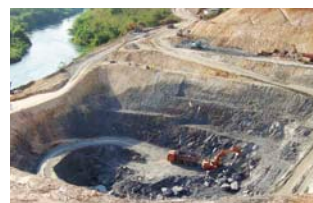
タクモ発電所の基礎掘削工事の状況
