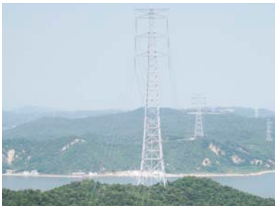
本四連系線(岡山県・香川県) 瀬戸内海を横断し本州と四国をつなぐ電圧50万ボルトの送電線です。本州・四国の基幹送電線と連結し、西日本における電気の安定的な供給に役立っています。
