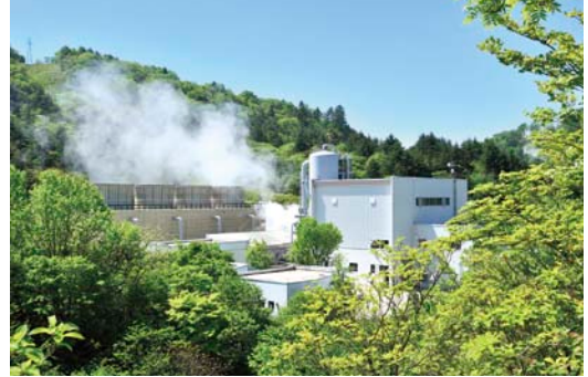
鬼首地熱発電所（宮城県）
