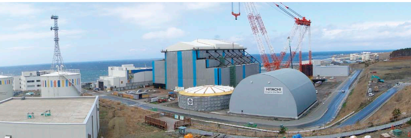
大間原子力発電所建設工事状況全景(青森県)
