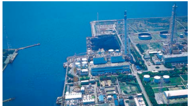
高砂火力発電所(兵庫県)
