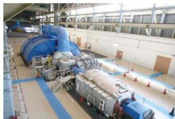
礪子火力発電所のタービン発電機
