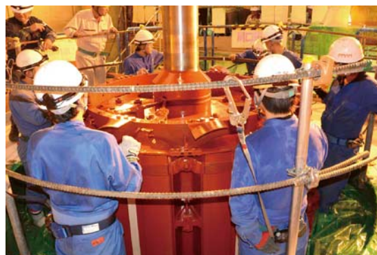
発電機(回転子)の吊り込みの様子(胆沢水力建設所(岩手県))
