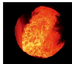
ボイラ内の様子
