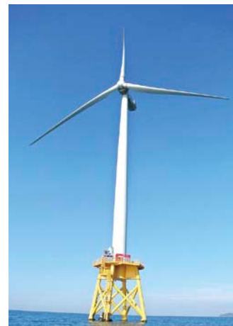
着床式洋上風力発電設備(北九州市)
