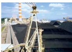
松島火力発電所貯炭場
