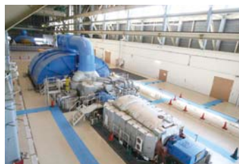
礪子火力発電所のタービン発電機
