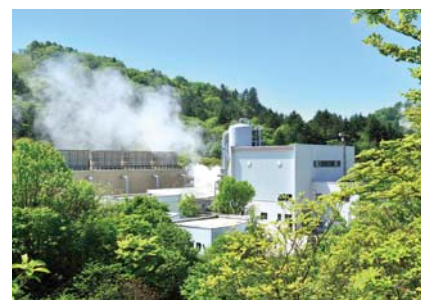
鬼首地熱発電所(宮城県)
