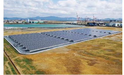
響灘太陽光発電所(北九州市)
