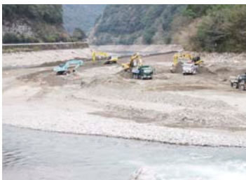
堆砂処理の様子(瀬戸石ダム/熊本県)
