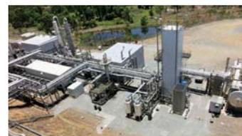
高濃度のCO<sub>2</sub>を含む排ガスを圧縮・冷却し高純度の液体CO<sub>2</sub>を回収
