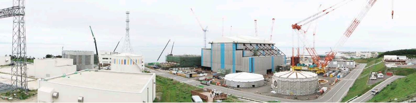
大間原子力発電所建設工事状況全景
