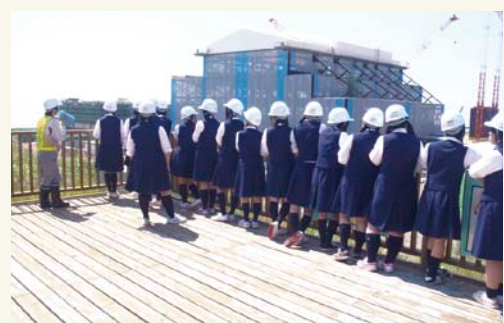
地元高校生が大間原子力発電所の建設現場を見学
