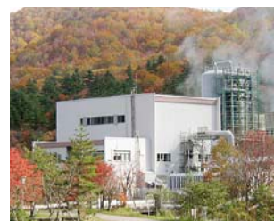
鬼首地熱発電所
