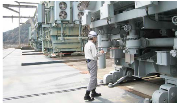
発電設備巡視点検の様子(佐久間発電所/静岡県)
