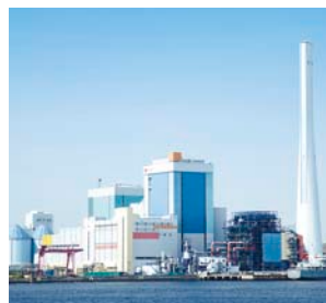
磯子火力発電所
