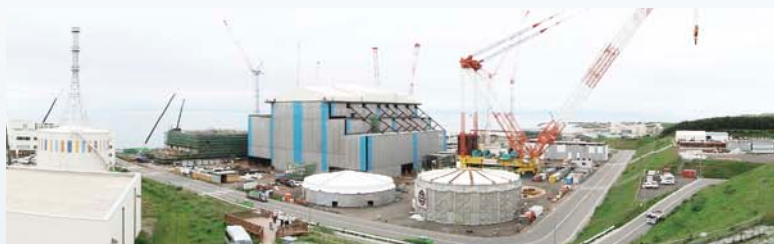
大間原子力発電所建設工事状況全景
