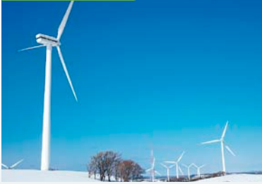
苫前ウィンビラ発電所
