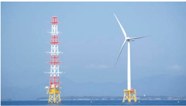
実証試験設備。(左)洋上風況観測設備 (右)着床式洋上風力発電設備
