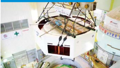
糠平発電所2号機固定子吊り込み作業
