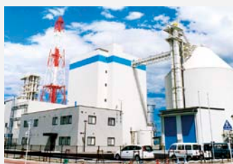
大牟田リサイクル発電所(福岡県)
