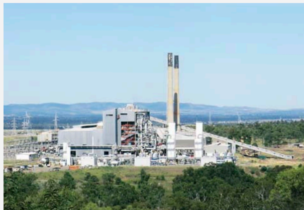
カライドA発電所(工事完了後)
