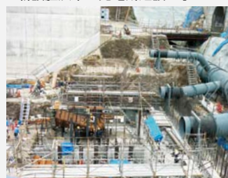
水圧鉄管据付状況 (2011年10月撮影)
