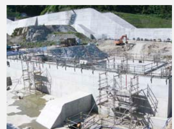
発電所基礎コンクリート施工状況 (2012年5月撮影)
