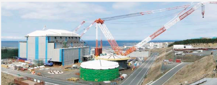
大間原子力発電所建設状況(2012年春)
