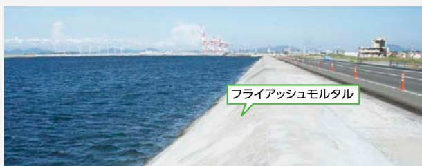
フライアッシュモルタル ※2 を利用した産業廃棄物最終処分場の表面遮水工 (J-POWER 響灘3号埋立地(北九州市))
