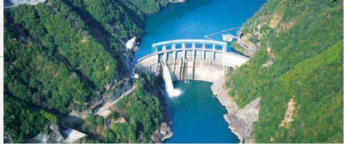
河川維持流量放流の様子 (二津野ダム/奈良県)
