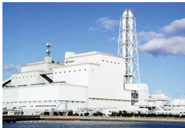
松浦火力発電所(長崎県)
