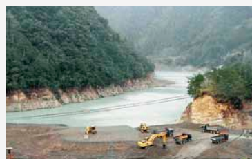
堆砂処理の様子(二津野調整池/奈良県)
