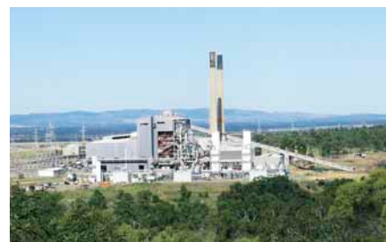
カライドA発電所(工事完了後)
