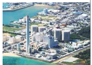
石川石炭火力発電所 (沖縄県)
