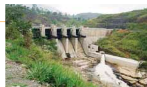
アップパーコトマレ水力（建設中/スリランカ）
