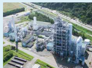
EAGLEパイロットプラント 試験設備外観(北九州市)
