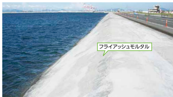
フライアッシュモルタル【用語集】を利用した産業廃棄物最終処分場の表面遮水工(J-POWER 響灘3号埋立地(北九州市))
