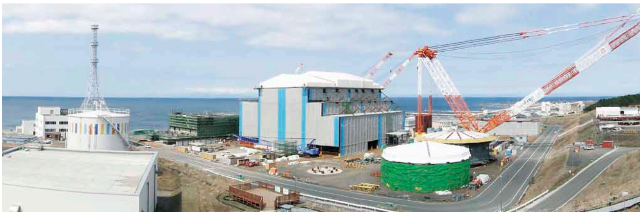
大間原子力発電所建設状況(2012年春)
