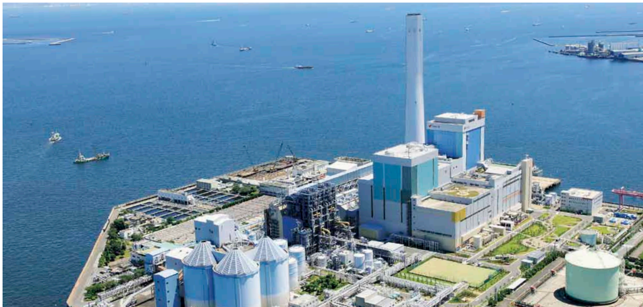
磯子火力発電所(横浜市)
