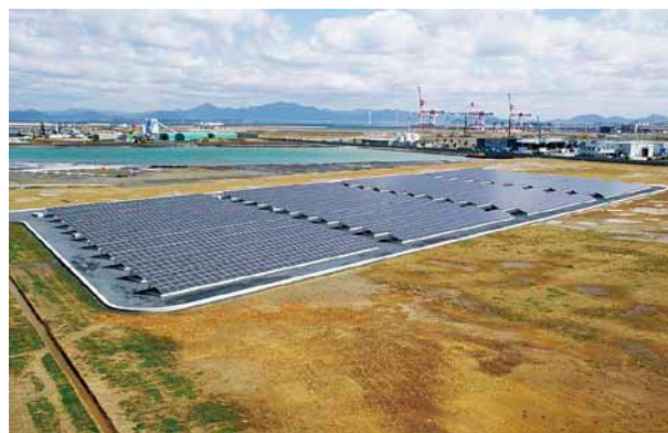
響灘太陽光発電所(北九州市)
