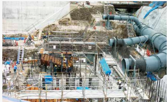
水圧鉄管据付状況(2011年10月撮影)
