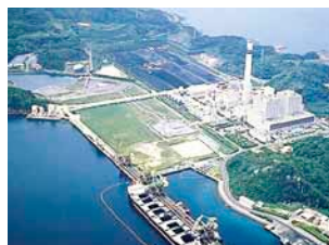
松島火力発電所 (長崎県)
