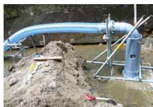
土砂の吸引実験の様子
