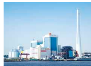
磯子火力発電所(横浜市)
