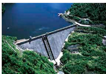
奥只見発電所(福島県)
