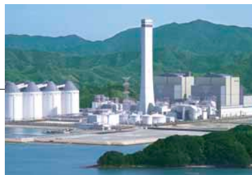
橘湾火力発電所(徳島県)
