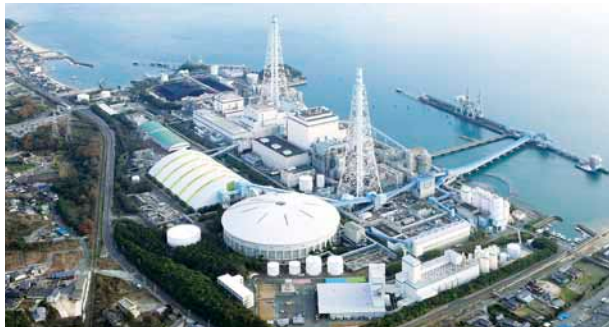
竹原火力発電所（広島県）
