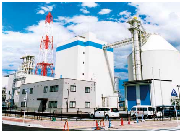
大牟田リサイクル発電所(福岡県)
