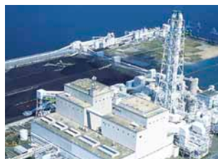
松浦火力発電所(長崎県)
