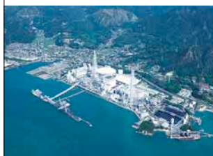
竹原火力発電所(広島県)
