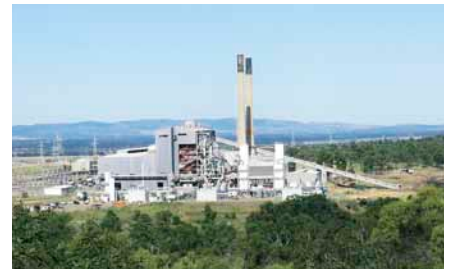
カライドA発電所(工事完了後)
