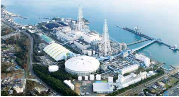
竹原火力発電所(広島県)
