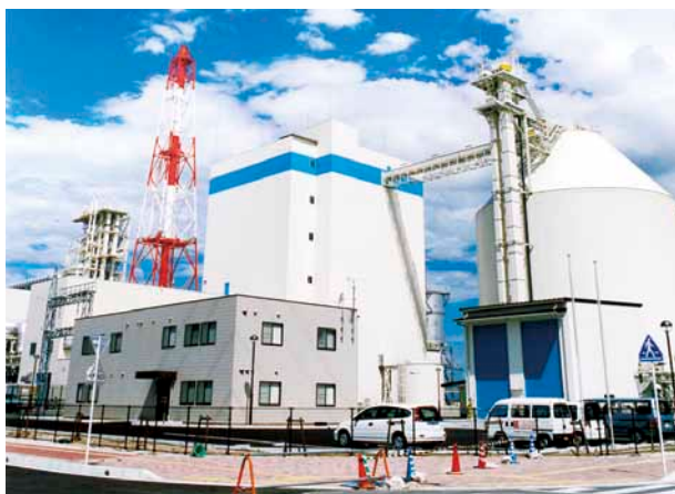
大牟田リサイクル発電所(福岡県)
