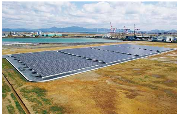
響灘太陽光発電所(北九州市)
