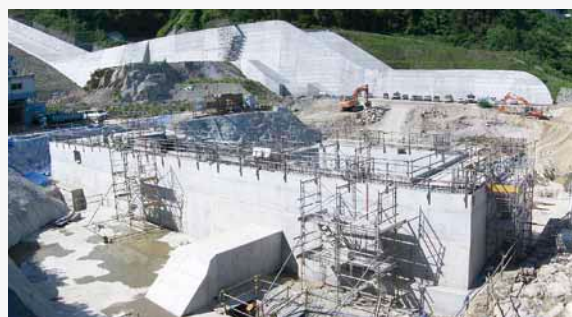
発電所基礎コンクリート施工状況(2012年5月撮影)
