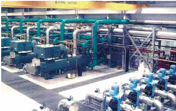
熱供給プラント内観
