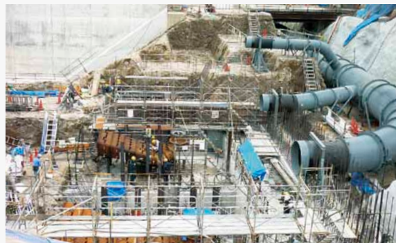
水圧鉄管据付状況(2011年10月撮影)
