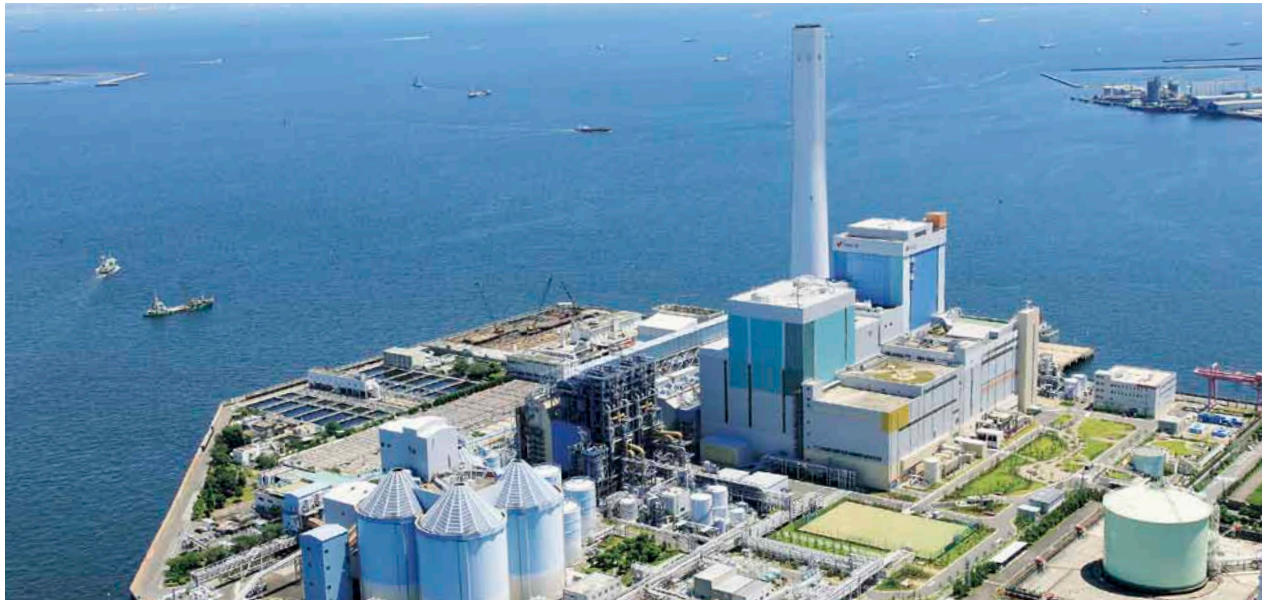
磯子火力発電所(横浜市)
