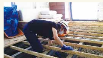
床下の泥出し作業
