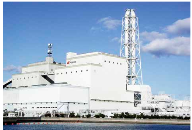
松浦火力発電所(長崎県)
