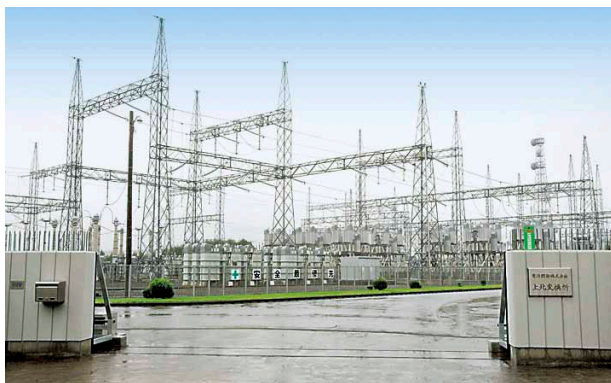
北本連系設備 上北変換所 (青森県)
