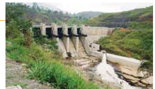
アッパーコトマレ水力(建設中/スリランカ)
