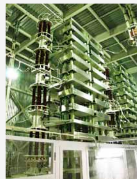
北本連系設備 函館変換所（函館市）
