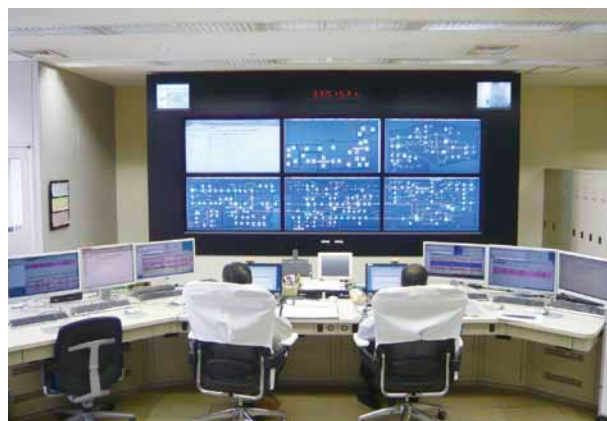
ネットワーク監視センター
