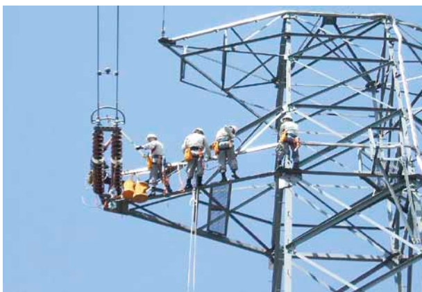
佐野送電技能訓練センター（栃木県）
