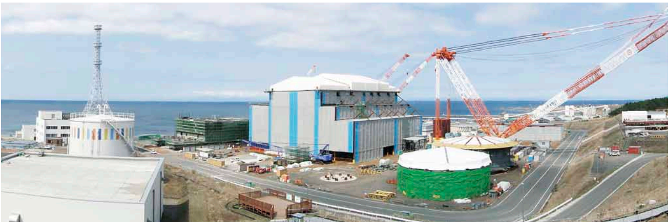
大間原子力発電所建設状況(2012年春)
