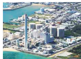
石川石炭火力発電所 (沖縄県)
