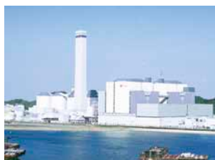
橋湾火力発電所(徳島県)
