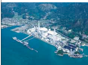
竹原火力発電所(広島県)
