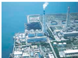
高砂火力発電所 (兵庫県)
