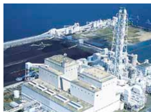
松浦火力発電所(長崎県)
