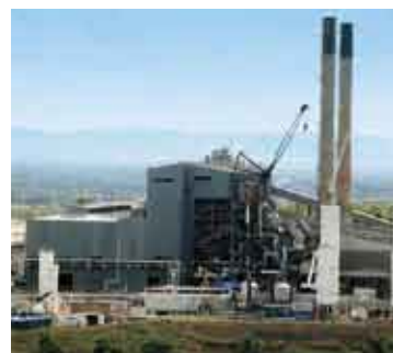
カライドA発電所(改造工事中)
