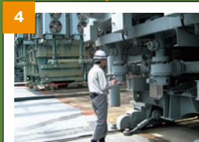
4 変圧器巡視点検
