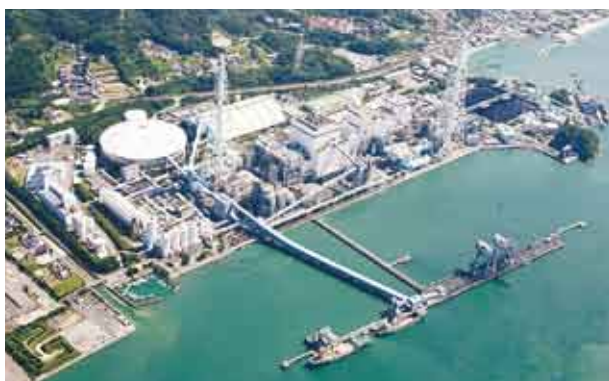
竹原火力発電所(広島県)
