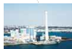
磯子火力発電所
