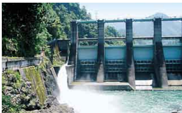
小森ダム（三重県） 河川維持流量放流の様子
