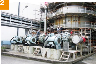
排煙脱硫装置の点検
