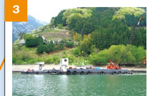
3 佐久間貯水池 浚渫作業(浚渫船)
