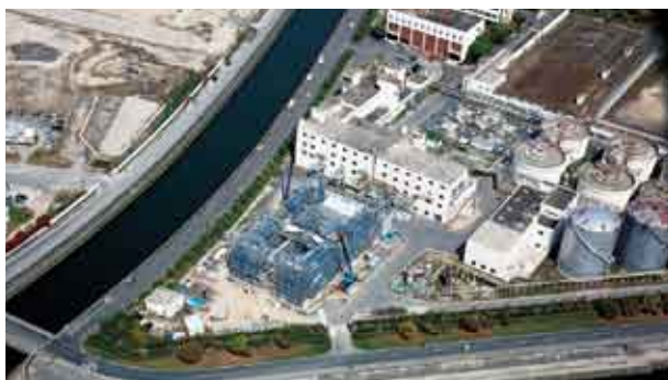
建設中の下水汚泥燃料化施設(広島市西部水資源再生センター)
