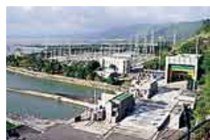
カラヤン揚水発電所(フィリピン)
