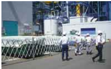
廃棄物リスク診断の状況(礪子火力発電所/神奈川県)
