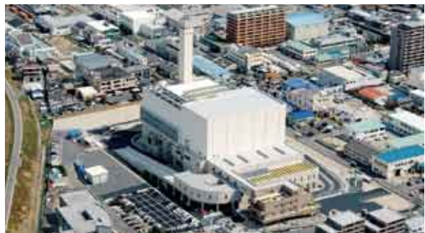
名古屋市鳴海工場
