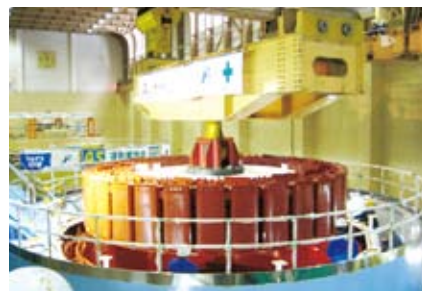
田子倉発電所(福島県) 一括更新工事
