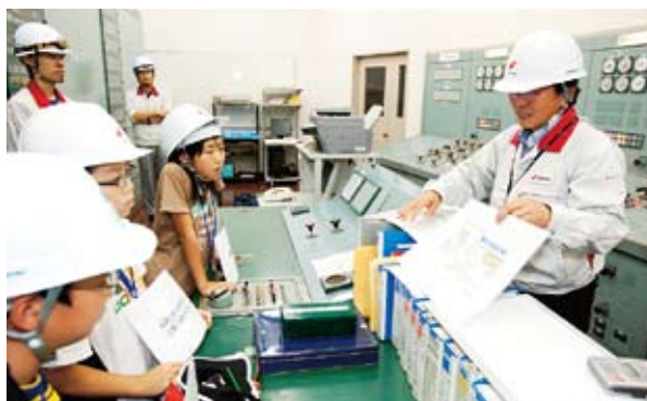
発電所内を親子で見学中(御母衣発電所/岐阜県)
