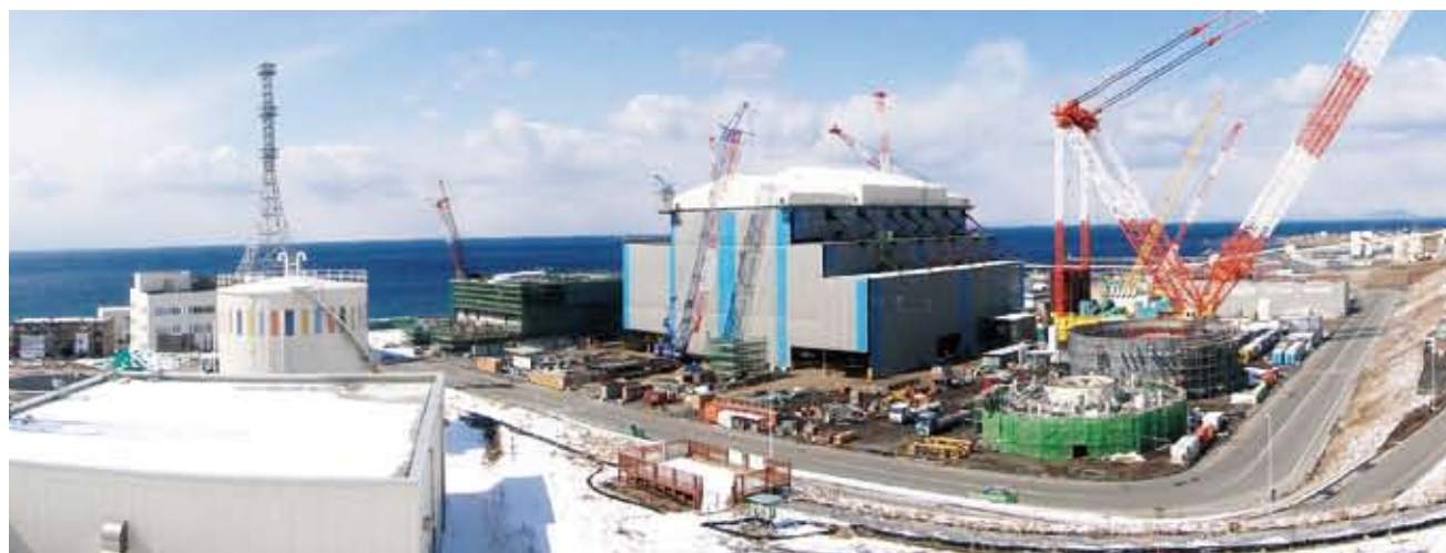
大間原子力発電所建設状況(2011年3月)
