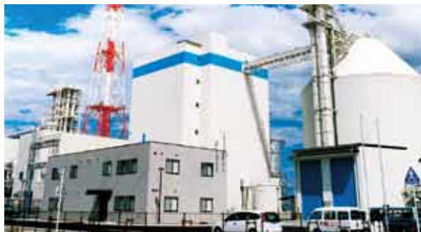
大牟田リサイクル発電所(福岡県)
