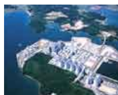
橘湾火力発電所
