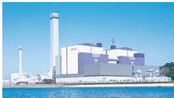
橘湾火力発電所(徳島県)
