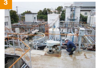
総合排水処理装置の点検
