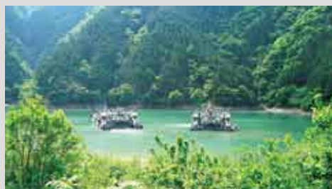
浚渫船（佐久間ダム／静岡県・長野県）
