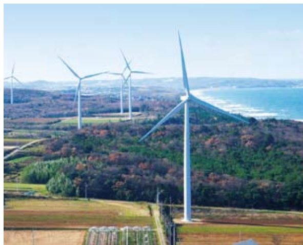
あわら北潟風力発電所(福井県)
