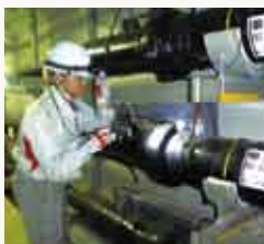
本四連系線巡視作業
