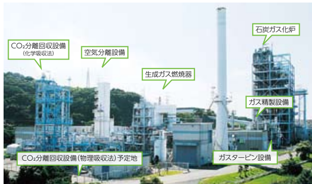
EAGLEパイロットプラント試験設備外観（北九州市若松区）
