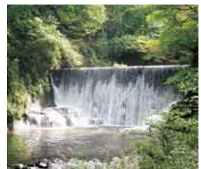
小水力発電の導入が期待される既設砂防えん堤
