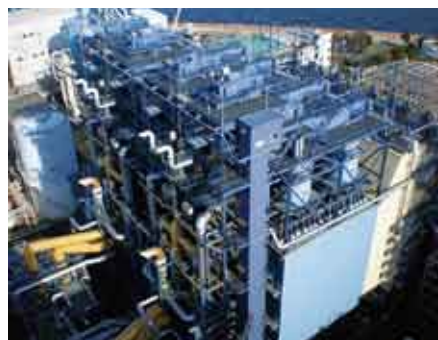
J-POWER礫子火力発電所向け乾式脱硫脱硝装置
