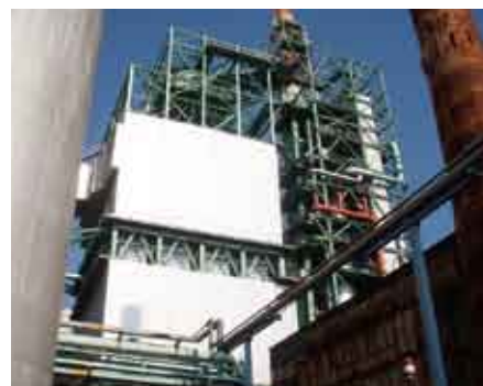
住友金属工業(株)和歌山製鉄所向け排ガス処理装置
