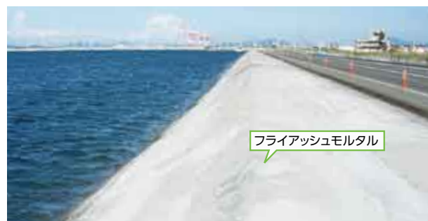
フライアッシュモルタルを利用した産業廃棄物最終処分場の表面遮水工 (J-POWER 響灘3号埋立地(北九州市))
