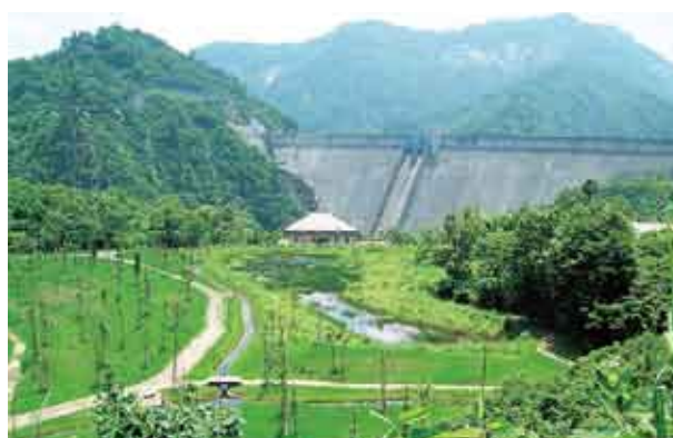
奥只見発電所 湿地復元地
