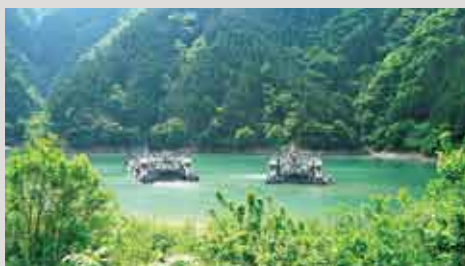
浚渫船(佐久間ダム/静岡県・長野県)
