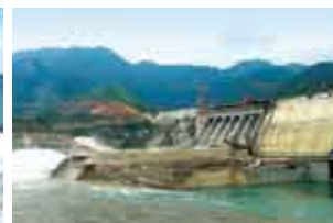
ソラ水力発電所(ベトナム)
