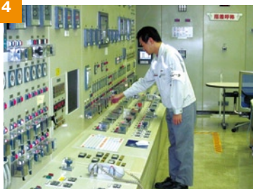
中央制御室での監視
