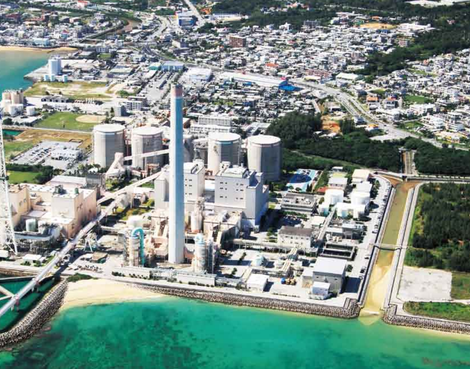
石川石炭火力発電所(沖縄県)
