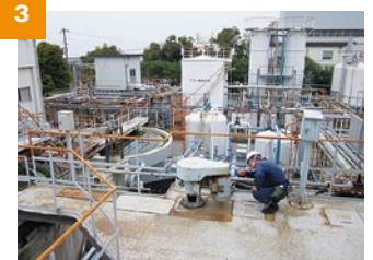
総合排水処理装置の点検
