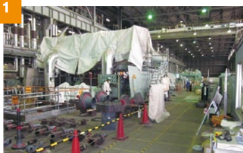
定期点検中の1号機(手前が1号機蒸気タービン)
