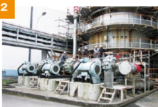
排煙脱硫装置の点検
