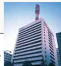
本店通信鉄塔設備
