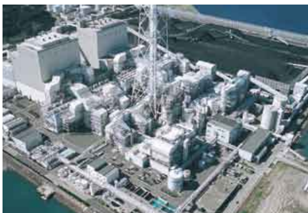
松浦火力発電所(長崎県)
