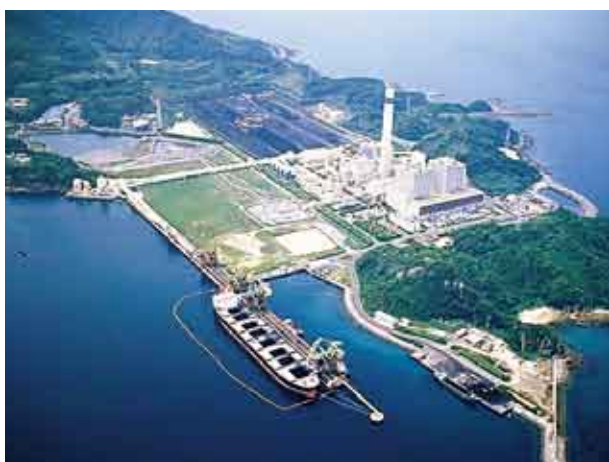
松島火力発電所(長崎県)
