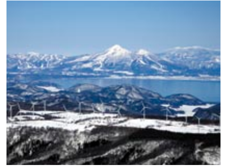
郡山布引高原風力発電所（福島県）
