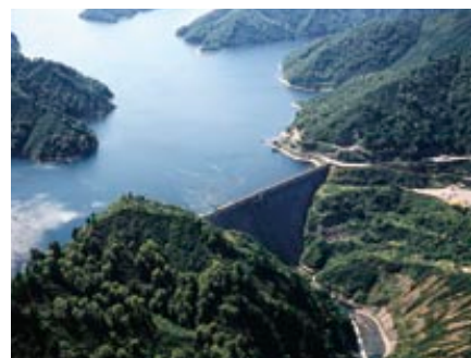
奥只見発電所(福島県)
