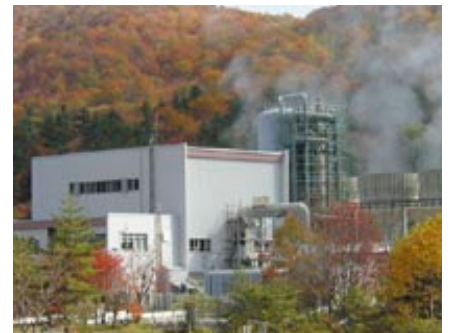
鬼首地熱発電所（宮城県）
