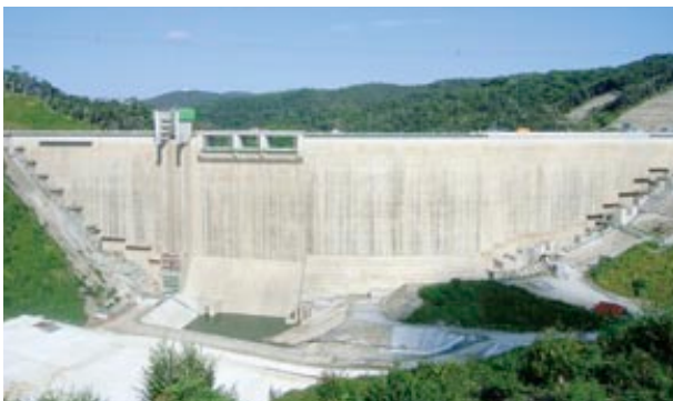
ジェイパウダー(フライアッシュ)をコンクリート混和材として活用したダム
