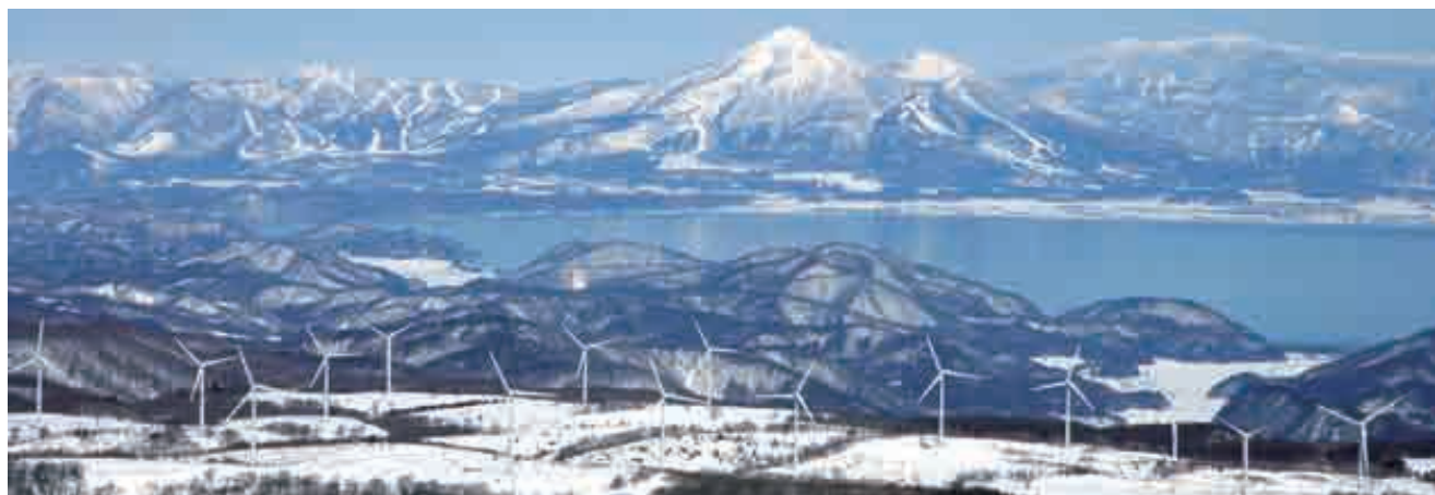
こおりやまのびまこうげん 郡山布引高原風力発電所(福島県)
