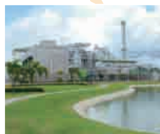
ロイエットもみ殻火力発電所
