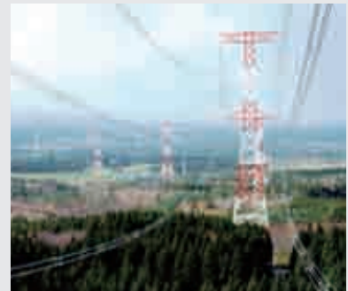
工事が完了した大間幹線（青森県）
