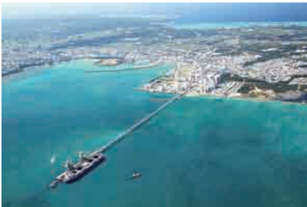
揚炭棧橋に着積中の石炭輸送船(石川石炭火力発電所／沖縄県)
