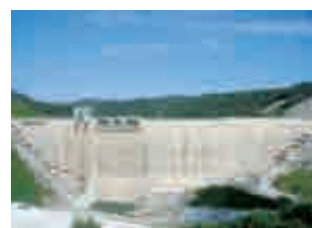
ジェイパウダー(フライアッシュ 用語集 )をコンクリート混和材として活用したダム
