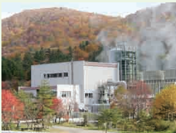
鬼首地熱発電所(宮城県)
