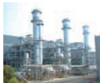
嘉恵ガス火力発電所(台湾)
