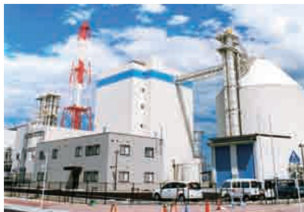
大牟田リサイクル発電所(福岡県)
