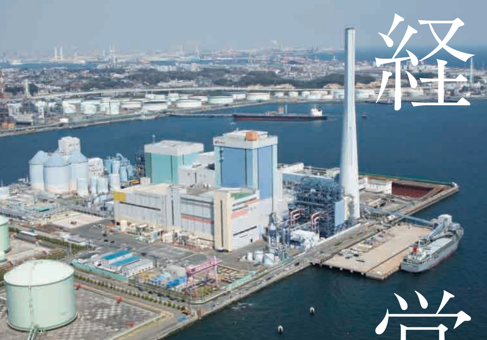
磯子火力発電所 (横浜市)
