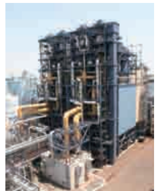
磯子火力発電所新2号機 乾式排煙脱硫装置(横浜市)
