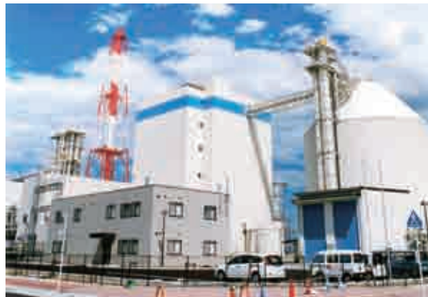
大牟田リサイクル発電所(福岡県)
