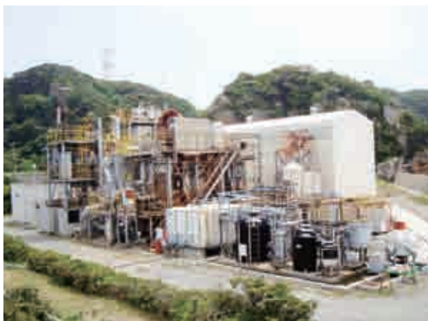
一般廃棄物の炭化燃料製造実証試験設備 松島火力発電所構内(長崎県)
