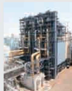
磯子火力発電所新2号機 乾式排煙脱硫装置(横浜市)
