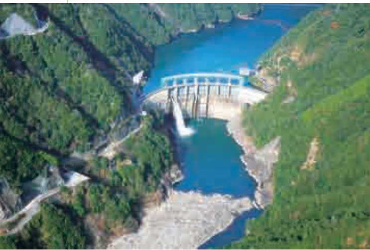
二津野ダム(奈良県)の河川維持流量放流状況
