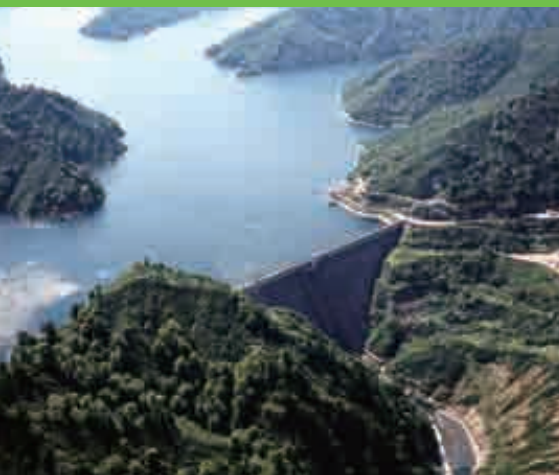
奥只見発電所(福島県)
