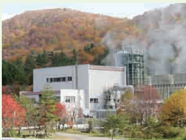
鬼首地熱発電所(宮城県)
