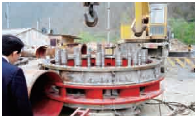
中国陝西省太白観音峡水力発電所 水車ランナー・ケーシング搬入
