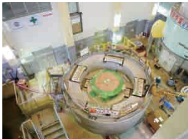
糠平発電所の主要設備一括更新工事
