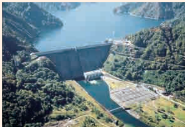
田子倉発電所(福島県)
