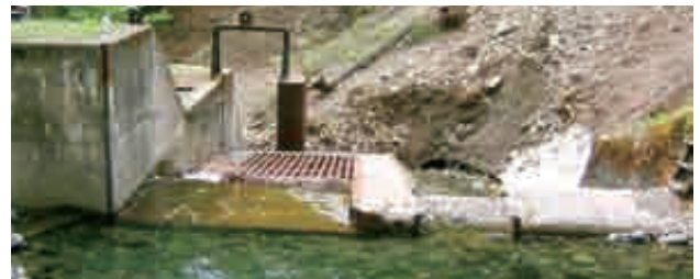
溪流取水設備(御母衣第二発電所小豆谷取水設備)
