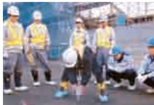
岩盤検査の様子
