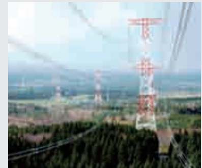
工事が完了した大間幹線(青森県)
