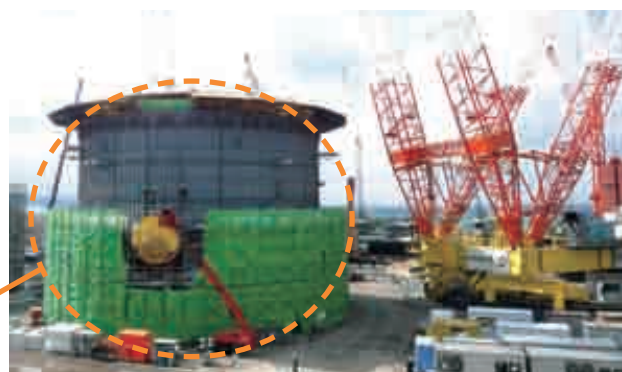
原子炉格納容器組み立て状況
