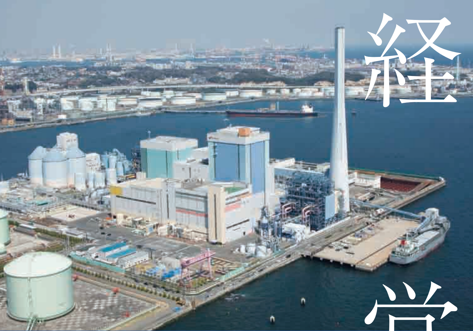
磯子火力発電所 (横浜市)
