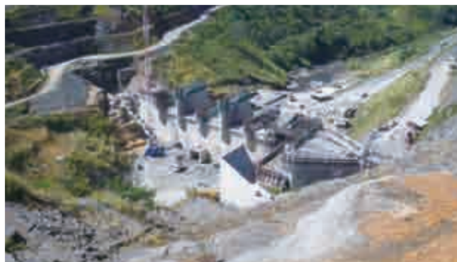
建設中の取水ダム
