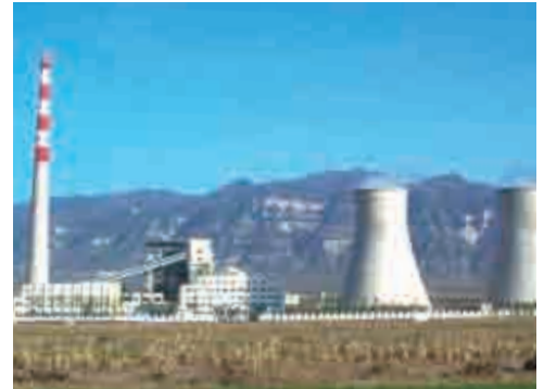
天石石炭火力発電所
