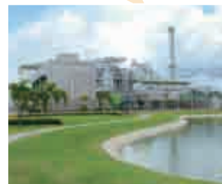
ロイエットもみ殻火力発電所
