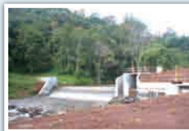
オロミス発電所の取水堰堤
