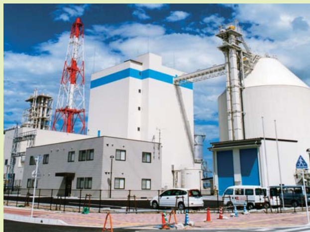
大牟田リサイクル発電所(福岡県)
