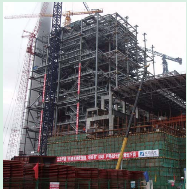
建設中の新昌火力発電所(中国)
