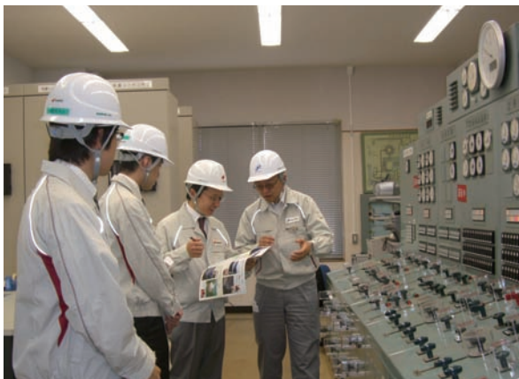
現場視察(小出電力所/新潟県)
