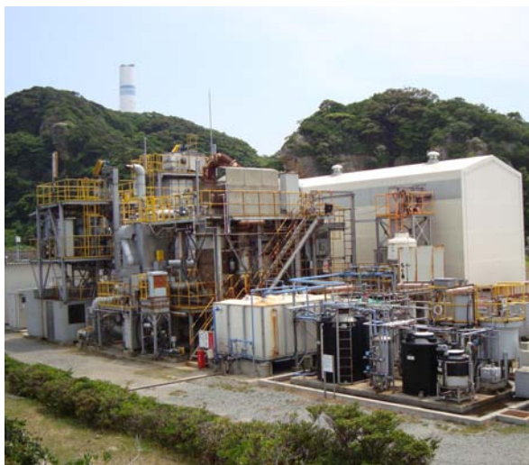
一般廃棄物の炭化燃料製造実証試験設備(松島火力発電所構内/長崎県)
