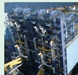
磯子火力発電所新2号機 乾式排煙脱硫装置(横浜市)
