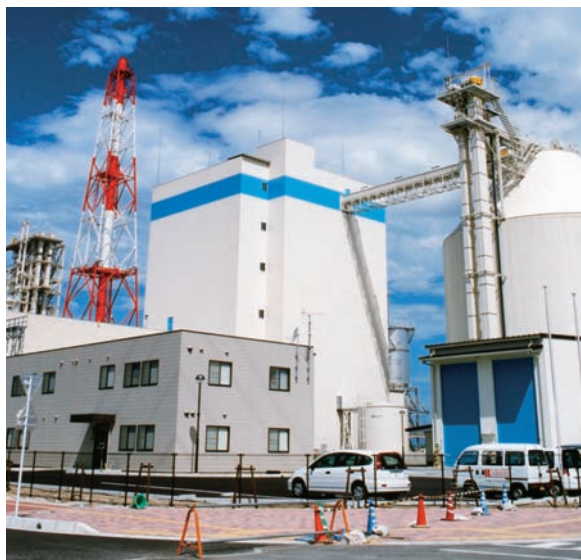
大牟田リサイクル発電所(福岡県)
