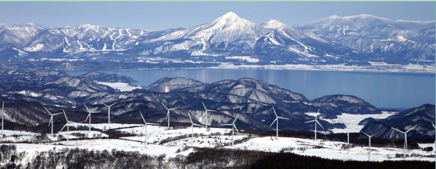
郡山布引高原風力発電所(福島県)
