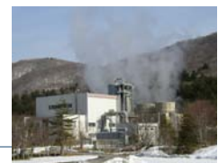
鬼首地熱発電所
