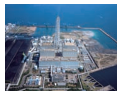
松浦火力発電所
