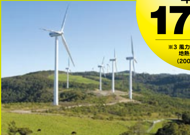
グリーンパワーくずまき風力発電所（岩手県）
