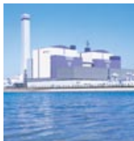
橘湾火力発電所(徳島県)
