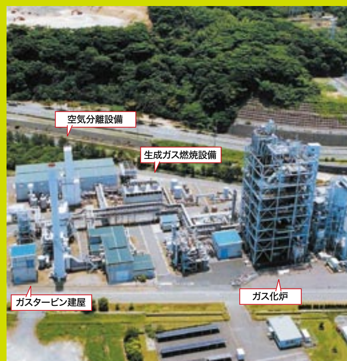
EAGLE試験設備
