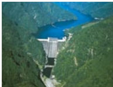
佐久間水力発電所（静岡県）
