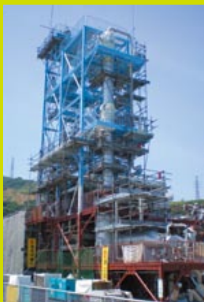
建設中のCO 2 分離回収設備
