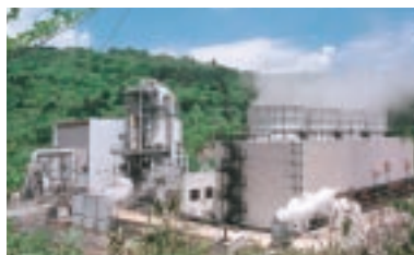
鬼首地熱発電所(宮城県)
