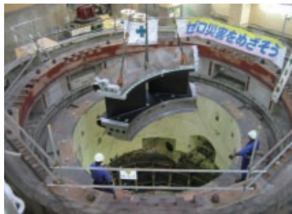
田子倉発電所主要設備一括更新工事 (福島県)
