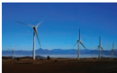
郡山布引高原風力発電所 (福島県)
