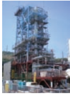
建設中のCO 2 分離回収設備
