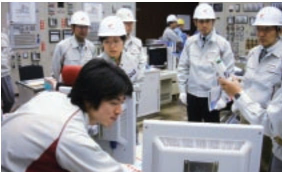
データ収集システムの確認(高砂火力発電所、兵庫県)
