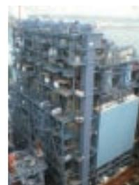
磯子火力発電所新2号機乾式排煙脱硫装置
