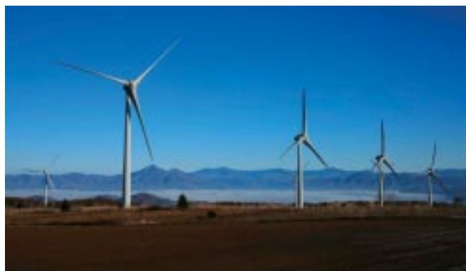
郡山布引高原風力発電所(福島県)
