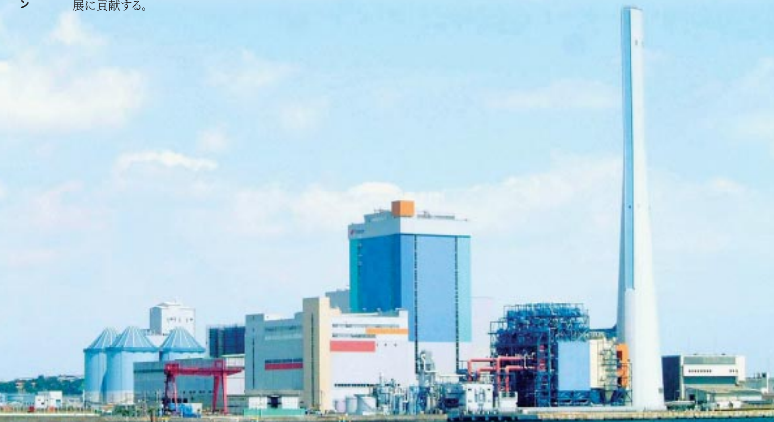
磯子火力発電所
