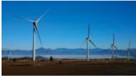
郡山布引高原風力発電所(福島県)
