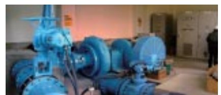
(株)開発設計コンサルタントが設計・施工管理した四日市市水道局(三重県)の水力発電所(320kW)
