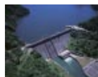
田子倉ダム・田子倉発電所（福島県）
