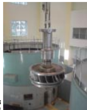
糠平発電所主要設備一括更新工事 (北海道)
