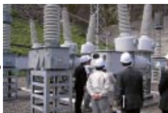
高知電力所 (高知県)
