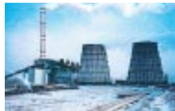
ウランバートル第4火力発電所改修計画(モンゴル)
