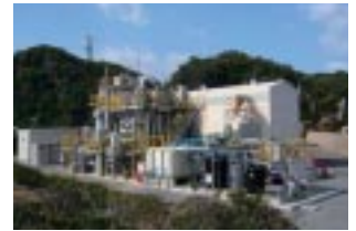
一般廃棄物の炭化燃料製造実証試験設備
