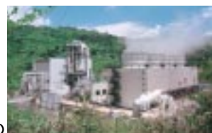
鬼首地熱発電所(宮城県)
