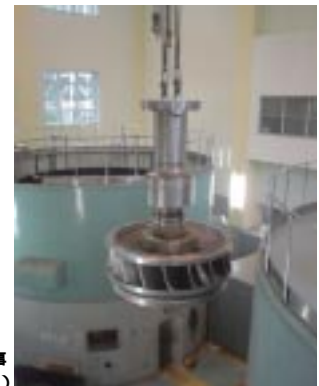
糠平発電所主要設備一括更新工事(北海道)
