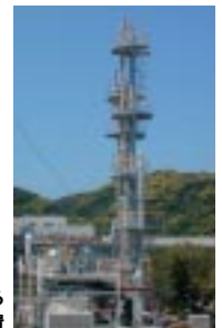
松島火力2号機におけるCO 2 分離回収実証試験装置
