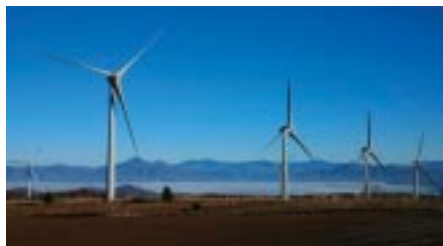
郡山布引高原風力発電所(福島県)
