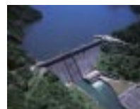
田子倉ダム・田子倉発電所(福島県)
