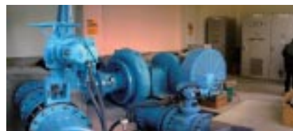
(株)開発設計コンサルタントが設計・施工管理した四日市市水道局(三重県)の水力発電所(320kW)
