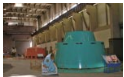
奥清津第二発電所(可変速揚水発電システム)
