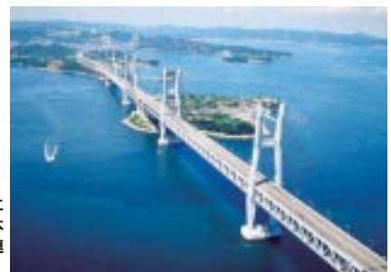
本四連絡橋(瀬戸大橋)に電力ケーブルをのせ、本州と四国をつなぐ本四連系統
