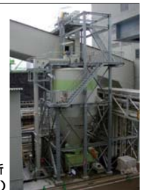
松浦火力発電所 バイオソリッド供給設備(長崎県)
