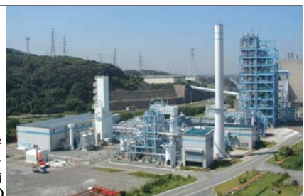
J-POWER若松研究所 EAGLEパイロット 試験設備 (福岡県)
