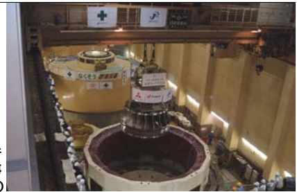
田子倉発電所 主要設備一括更新工事 (福島県)
