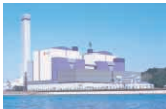
橘湾火力発電所(徳島県)
