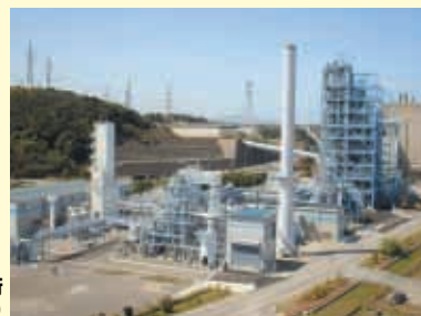
燃料電池用石炭ガス製造技術 パイロットプラント(福岡県)
