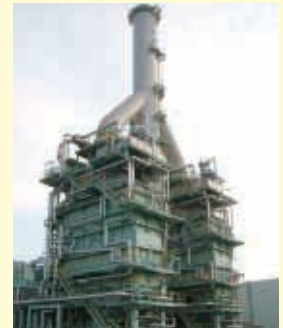
市原パワー(株)市原発電所 (千葉県)
