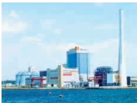
磯子火力発電所新1号機(神奈川県)
