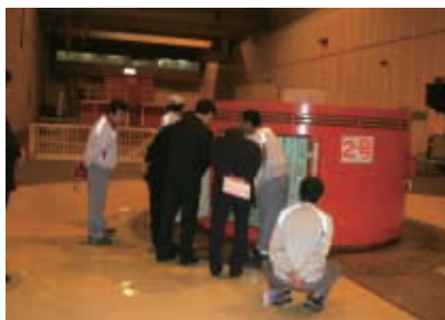
沼原電力所(栃木県)
