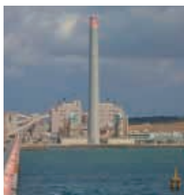
石川石炭火力発電所(沖縄県)
