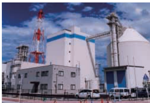
大牟田リサイクル発電事業 (非連結会社) 福岡県大牟田市：2002年12月稼働開始 一般廃棄物RDF発電事業として、高効率廃棄物発電を行っています。
