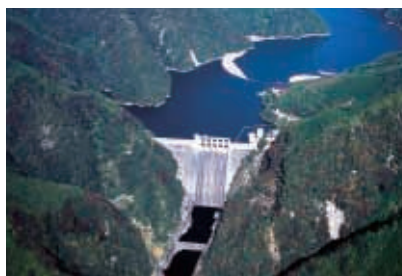
佐久間発電所(静岡県)
