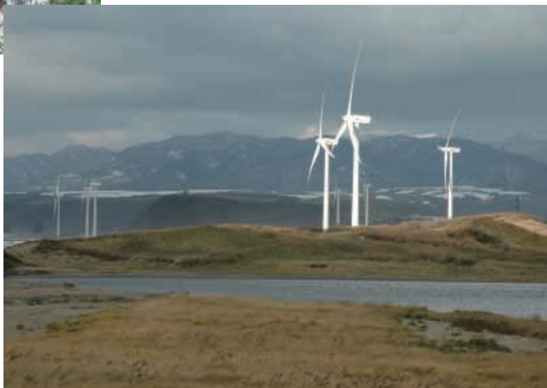
瀬棚臨海風力発電所(北海道)
